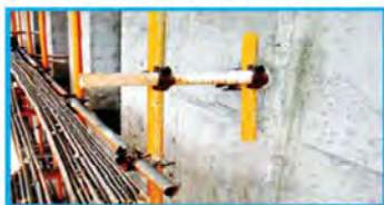
墙体预埋孔连墙件示例
