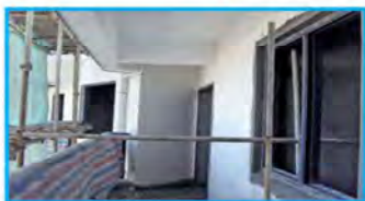
门、窗、洞连墙件示例
