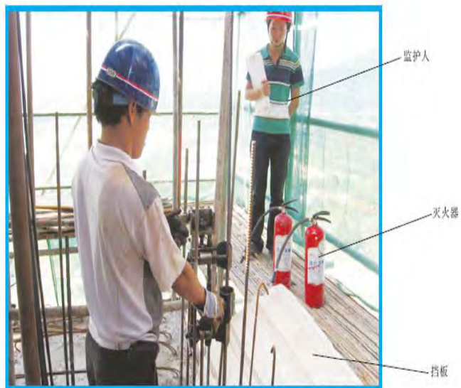
电渣压力焊作业安全示例
