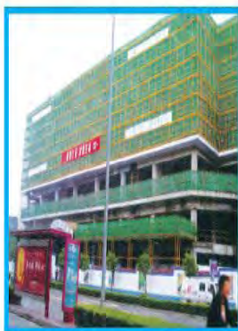
安全通道口防护棚示例五
