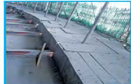
悬挑式脚手架兜底示意图
