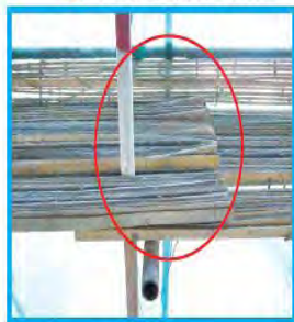
竹串片脚手板搭接铺设示例
