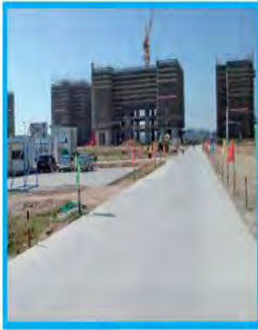
■ 施工主干道硬化示例一
