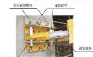
预留孔洞穿墙螺栓固定示例
