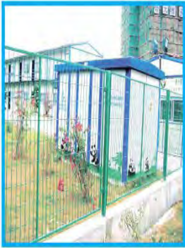
工地内部隔离围挡示例一
