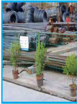
工地内部隔离围挡示例二
