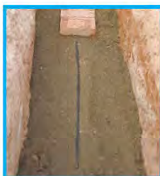
铠装电缆线直接埋地敷设示例
