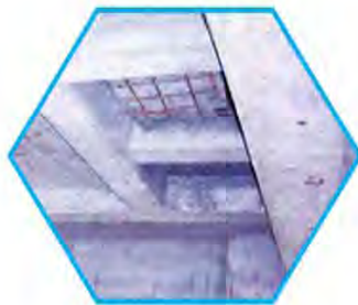
预留洞口防护示例
