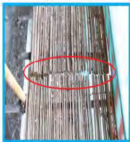
竹串片脚手板对接铺设示例
