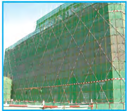
落地式钢管脚手架示例
