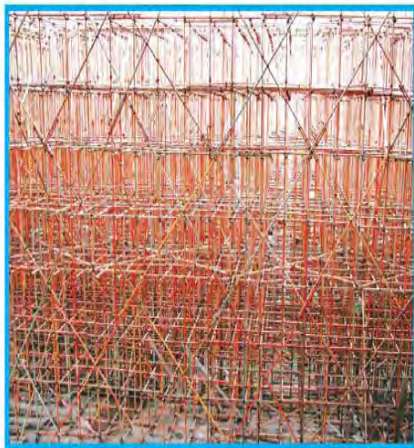
支架水平剪刀撑示例
