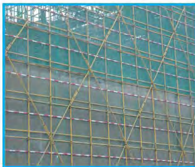
脚手架剪刀撑示例
