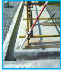
自然地面脚手架基础示例二
