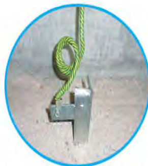
配电箱PE线重复接地示例
