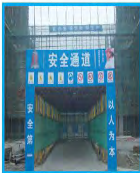
安全通道口防护棚示例二
