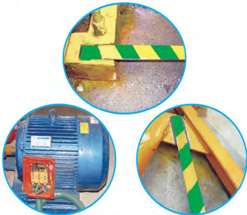
■ 电气设备接地与防雷示例
