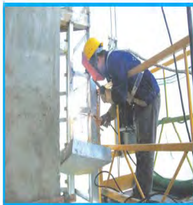
电焊作业安全示例
