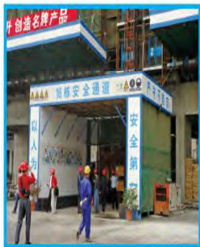
安全通道口防护棚示例一
