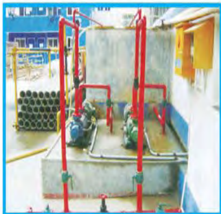
高层建筑消防水泵示例
