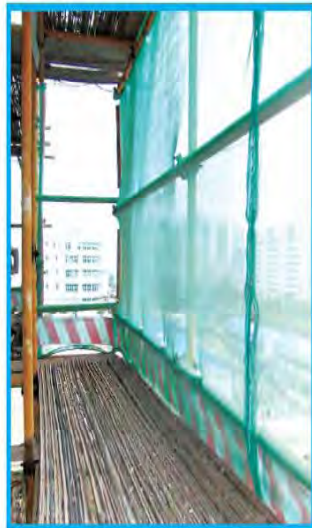
■ 栏杆扶手、挡脚板示例
