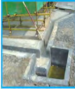
自然地面脚手架基础示例一
