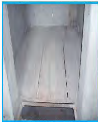
电梯井水平防护示例
