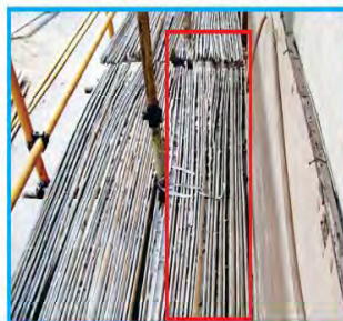
补离墙间距示例二 (使用竹串片防护)
