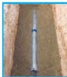
电缆加防护套管埋地敷设示例
