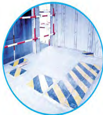
预留洞口防护示例
