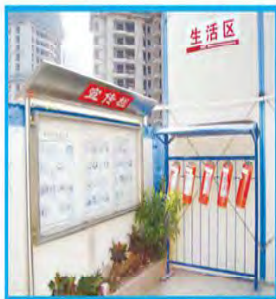
生活区配备消防器材示例
