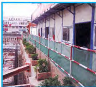
■ 基坑临边防护示例二
