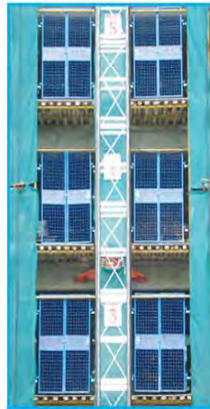
卸料平台防护门防护示意图
