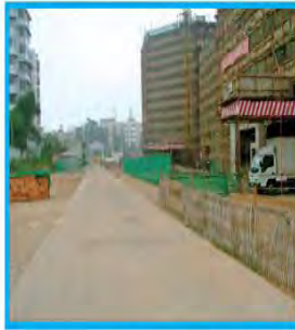
■ 施工主干道硬化示例二
