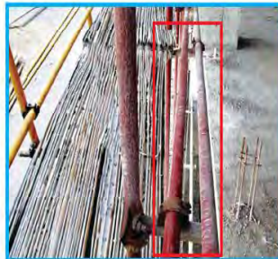
补离墙间距示例一 (使用钢管防护)
